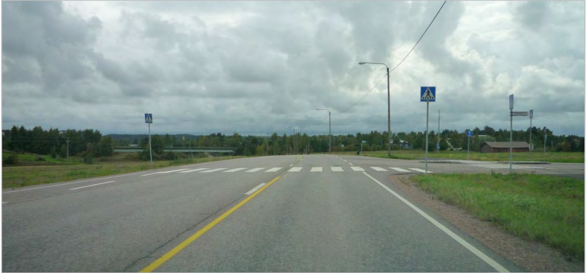
Kuva 19. Maantien 1494 (Pornaistentie) geometrian takia heikosti havaittavissa oleva suojatie Kartanontien liittymässä (toimenpiteenä suojatien keskisaarekkeen rakentaminen nykyisen suoja-tien kohdalle ja heijastinvarret).
