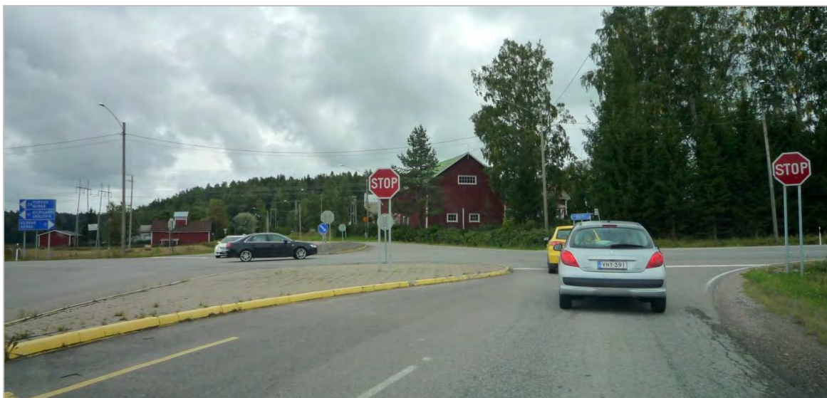
Kuva 23. Maantien 148 (Öljytie) ja maantien 11697 (Brobölientien) liittymä, joka on liikenneonnettomuuksien määrällä mitaten Sipoon turvattomin tasoliittymä (toimenpiteenä ensimmäisessä vaiheessa turvasaarekkeen rakentaminen Brobölientielle sekä näkemien parantaminen).
