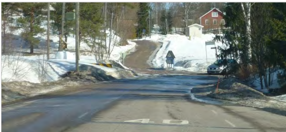
Kuva 25. Borgbyn koulun kohdan turvaton kevyen liikenteen ylityskohta maantiellä 1494 (Pornais-tentie). Vuonna 2012 valmistuvan Nikkilän ja Linnanpellon välisen kevyen liikenteen väylän yhteydessä tien ylityksen turvallisuutta parannetaan rakentamalla keskisaarekkeellinen suojatie.
