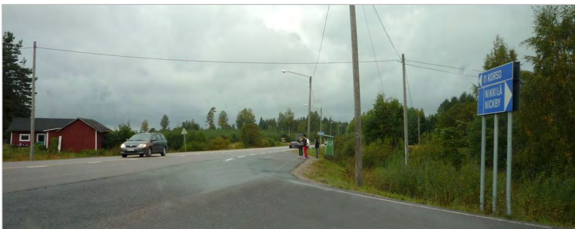
Kuva 24. Maantien 1521 (Nikkiläntie) bussipysäkki Martinkyläntien liittymässä (toimenpiteenä ensimmäisessä vaiheessa kevyen liikenteen yhteyden rakentaminen pysäkillä).
