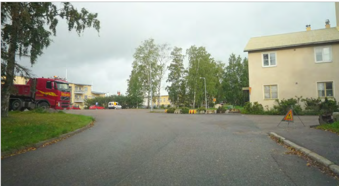
Kuva 20. Isotalontien ja Jussaksentien jäsentymätön liittymäalue (toimenpiteenä mm. liittymäalueen kokonaisvaltainen parantaminen).
