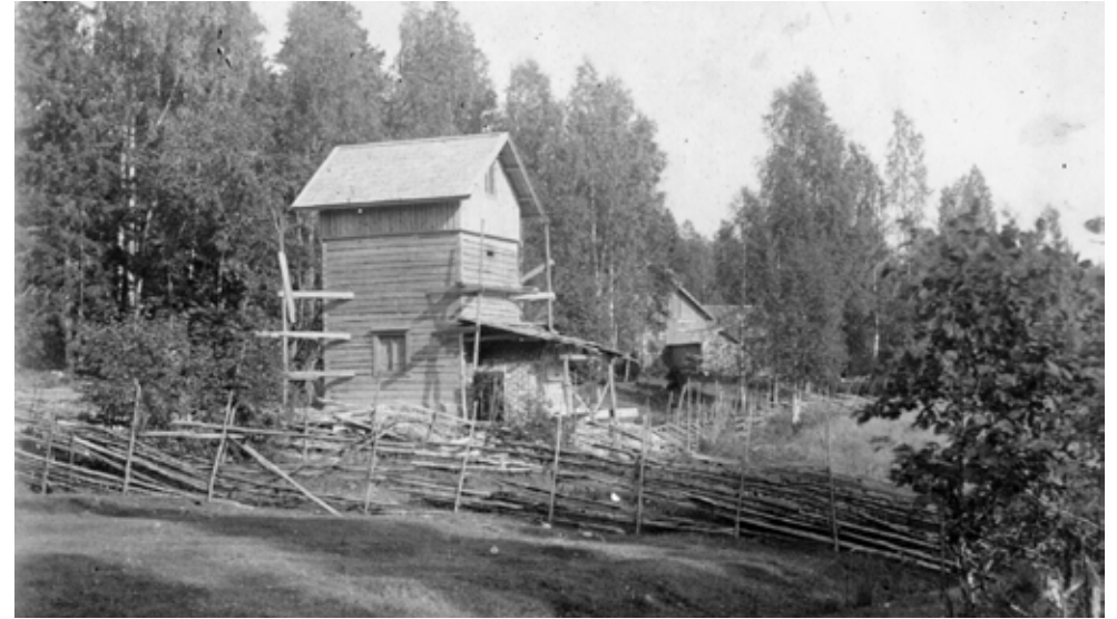
Kuvassa Majvikin tilan uusi, ruotsalaisten mallipiirustusten mukaan rakennettu kuivausräikkö, joka on rakennettu 24, ja takana puimala. Kuva 1920-luvun alusta.
