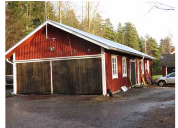
Svartvikin vanhan kasvihuoneen paikalle rakennettu autotalli, varasto ja vierastupa.
