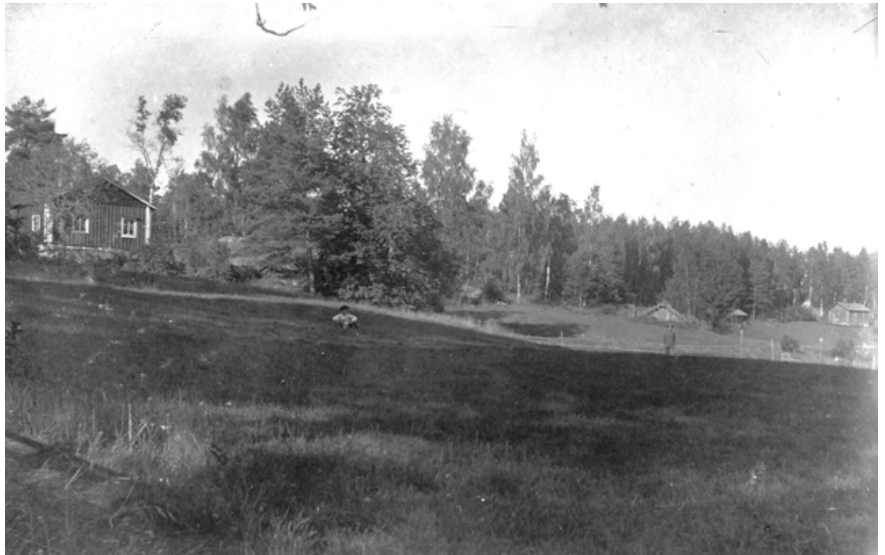
Kuvassa näkyy Svartvikin molemmat vanhat torpat. Vasemmanpuoleinen Svartvik södra torp on edelleen osa Svartvikin asuinrakennusta, oikeanpuoleinen Svartvik norra torp on ollut nykyisen Kinnasen talon lähellä. Kuvassa näkyy myös pellolla ollut perunakellari ja Svartvik norran navetta, joka pilkistää puiden lomassa.
