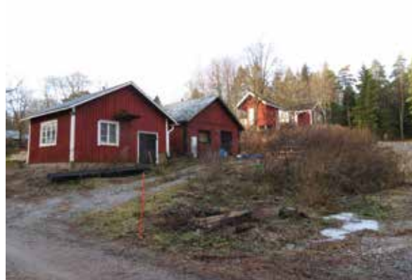
Alinna Svartvikin pakkaushuone, sen yläpuolella alempi pannuhuone.
