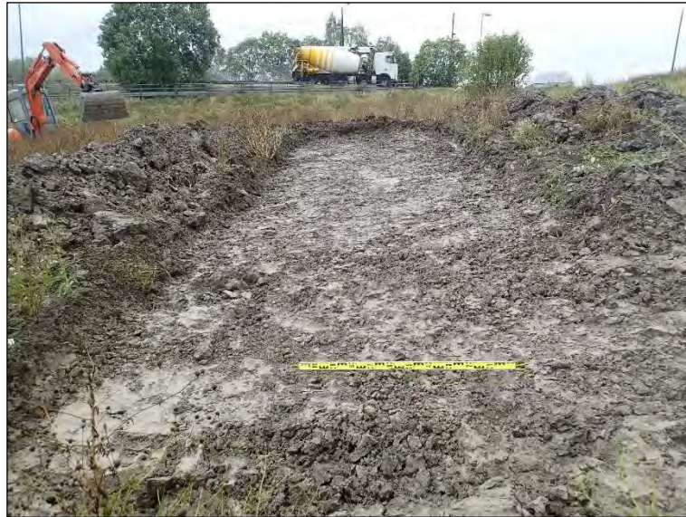
Tallbacka 1A, alue 2. Kaivausalue 86,4 m 2 . Kuva pohjoiseen.
