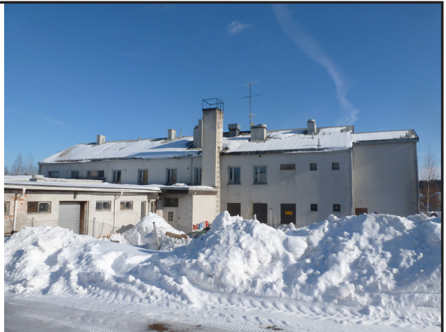
Iso Kylätien varressa sijaitseva kaksikerroksinen, satulakattainen rapattu liikerakennus v. 1943. Rakennus on mm. perustuksiltaan erittäin huonossa kunnossa. Affärsbyggnaden i två våningar med rappid fasad och sadeltak vid Stora Byvägen är från år 1943. Byggnaden är i mycket dåligt skick bl.a. när det gäller fundamenten.
