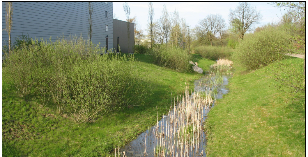
Kuva 5. Esimerkki hulevesien viivytysohjeesta. 6
