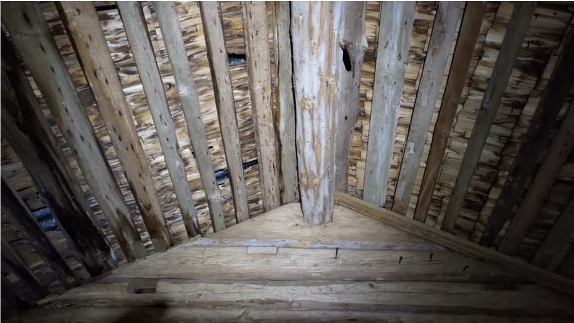
Kuva 4. Aitan kattorakenne on ihanteellinen lepakoille; peltikatto, jonka alla vanha pärekatto.
