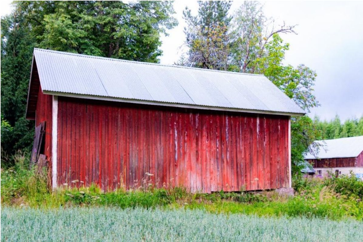
Kuva 11. Asuinrakennuksen pohjoispuolella sijaitseva ulkorakennus.
